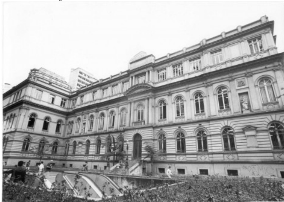
Figura 2 - Edifício antigo da Escola Normal Caetano de Campos - atualmente sede da Secretaria da Educação do Estado de São Paulo
